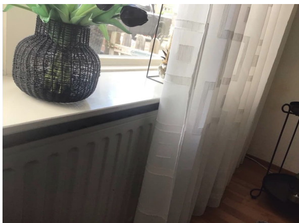
Vensterbank is van hout. Radiatoren zijn niet asbestverdacht.
