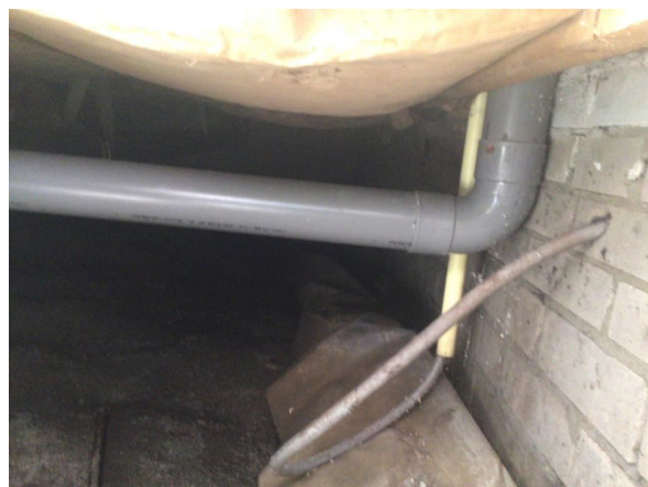
Riolering beperkt geïnspecteerd vanuit het kruipluik. Uitvoering in pvc.
