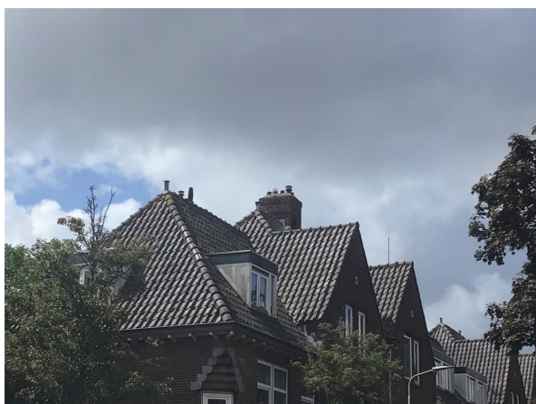
Rookgasafvoer en ontluchtingen op het dak zijn uitgevoerd in kunststof of gres.
