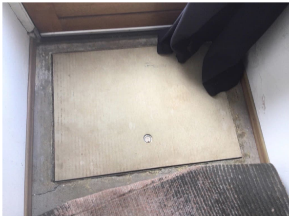
Kruipluiken zijn niet asbestverdacht.
