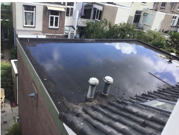
Bitumineuze dakbedekking is niet bemonsterd, dit valt buiten de scope van het non-destructief onderzoek.
