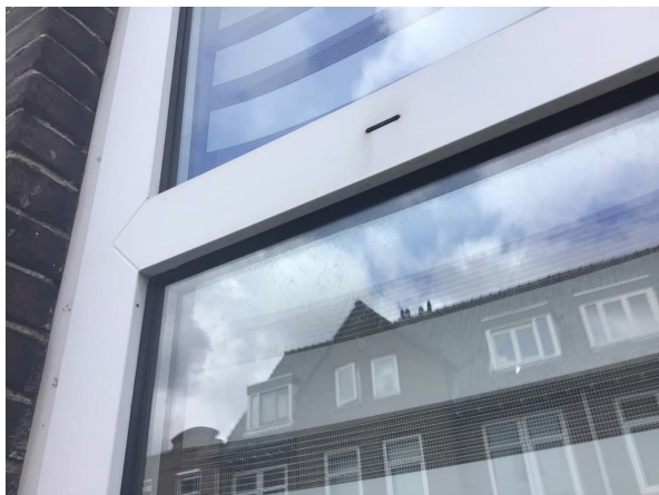
Beglazingsrubbers kunststof kozijnen, niet asbestverdacht.
