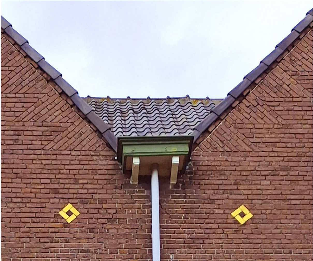
met boerenvlechting en bloktand in overgang naar kantpan
