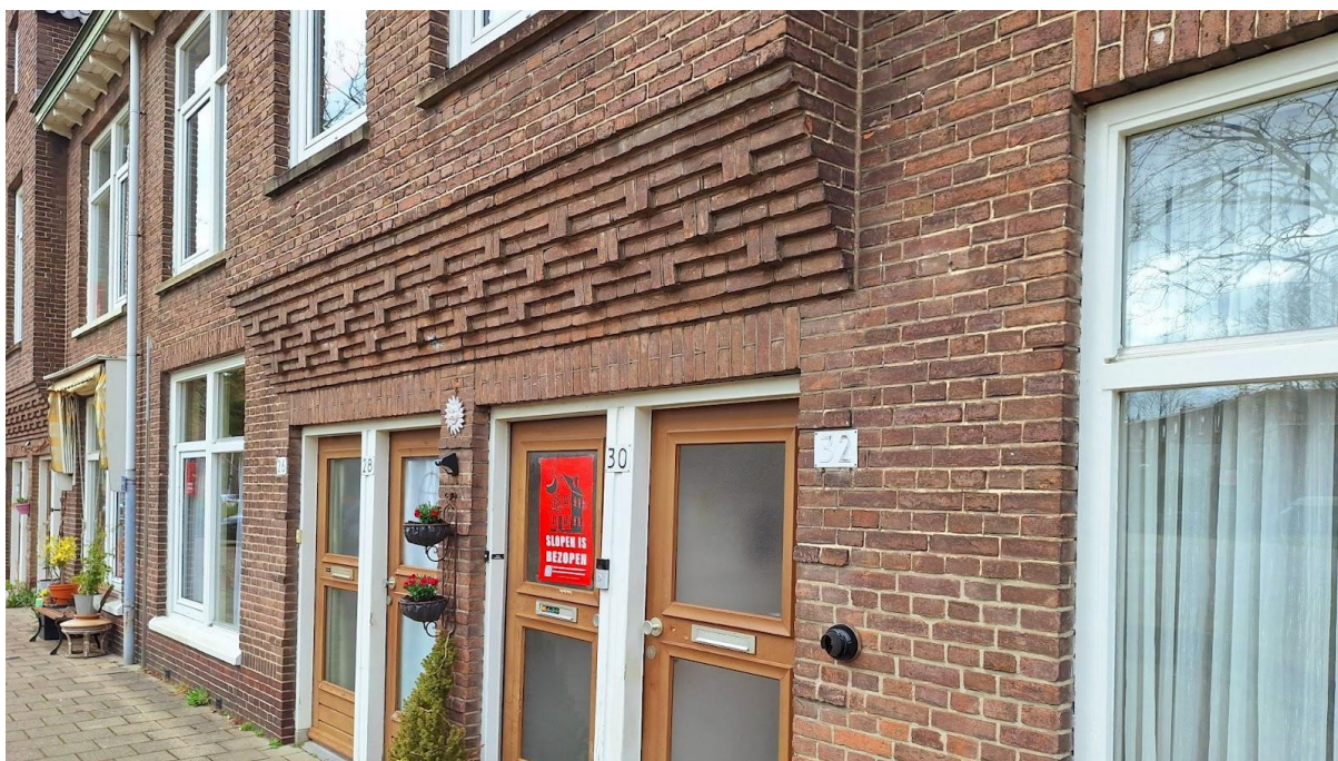
fraai metselwerk en afgrijselijk gerenoveerde jaren '80 voordeuren
