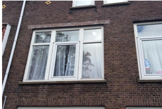
Bovenstaande foto's van de doorgezakte rollagen waarachter verroeste stalen lateien liggen en scheurvorming in de gevels
