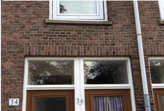
Bovenstaande foto's van de doorgezakte rollagen waarachter verroeste stalen lateien liggen en scheurvorming in de gevels
