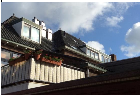
De slabben rondom de dakkapellen zijn asbest houdend.
