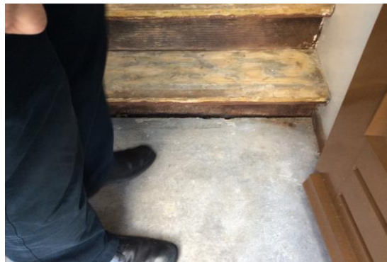
Op deze foto's is te zien dat de trapbomen houtrot vertonen. Oorzaak is optrekkend vocht vanuit de kruipruimte en funderingsbalken. Bij de aanwijzing zit de lasnaad van de vorige reparatie en een schroevendraaier onderin waar het nu weer rot is.. Door dit optrekkende vocht gaan ook de beganegrondvloeren houtrot vertonen en hogerevochtwaarden in de wanden.
