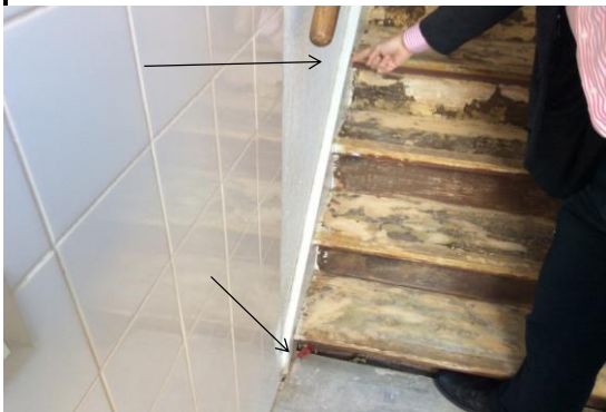
Op deze foto's is te zien dat de trapbomen houtrot vertonen. Oorzaak is optrekkend vocht vanuit de kruipruimte en funderingsbalken. Bij de aanwijzing zit de lasnaad van de vorige reparatie en een schroevendraaier onderin waar het nu weer rot is.. Door dit optrekkende vocht gaan ook de beganegrondvloeren houtrot vertonen en hogerevochtwaarden in de wanden.
