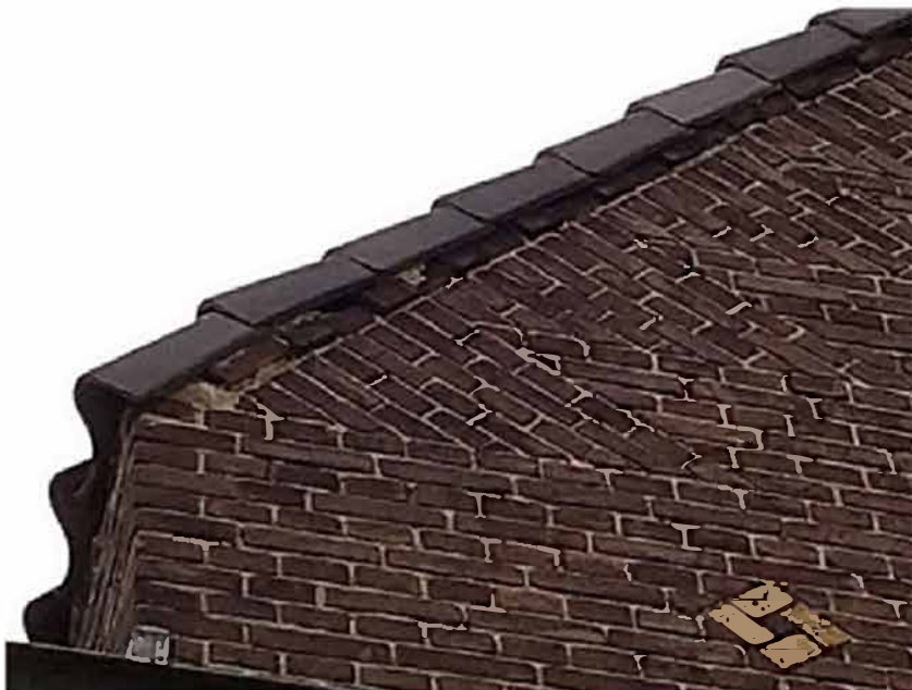
Afbeelding 8: Voor vogels en vleermuizen geschikte gevel in het plangebied. Ruimtes tussen gevels en dakpannen. Foto: [REDACTED]
