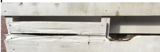
De slabben rondom de dakkapellen zijn asbest houdend.
